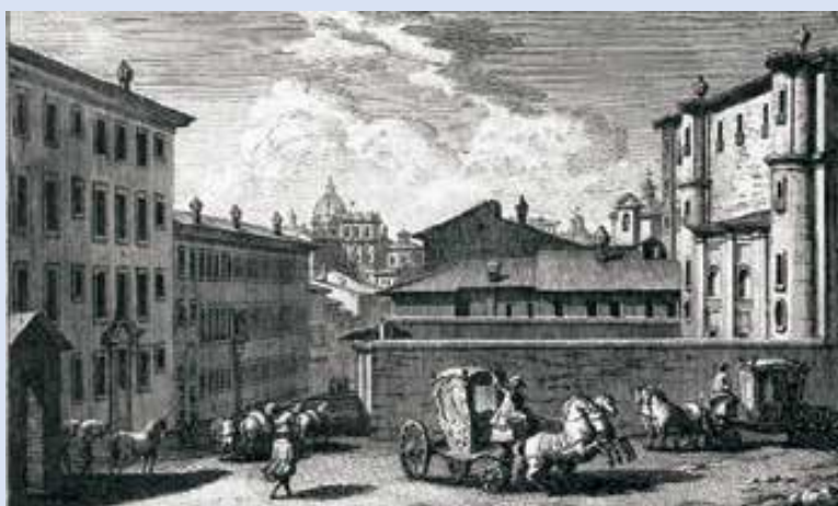
G. Vasi, Chiesa e monastero di Santa Maria dei Sette Dolori (a sinistra in secondo piano, la Manifattura tabacchi)
