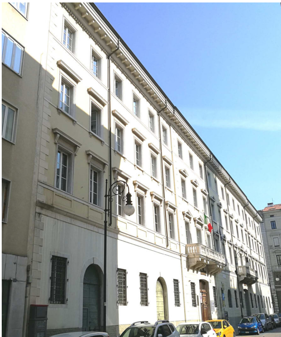
Foto 2: facciata principale da Via Corsi
