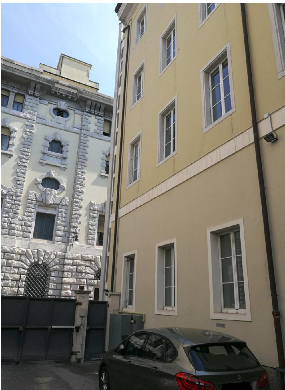
Foto 6a: facciata postica (corte interna)
