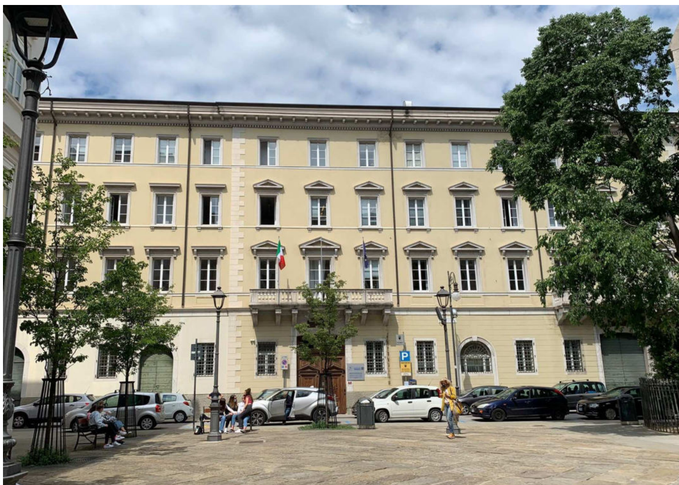
Foto 1: facciata principale su Largo Panfili
